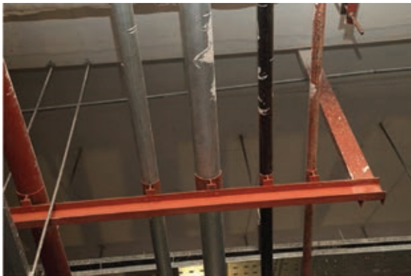
شکل ۱۶- آویز چند لوله‌ای
