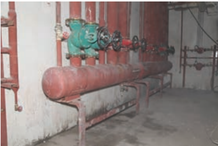
شکل ۱- نصب شیر تخلیه کلکتور
