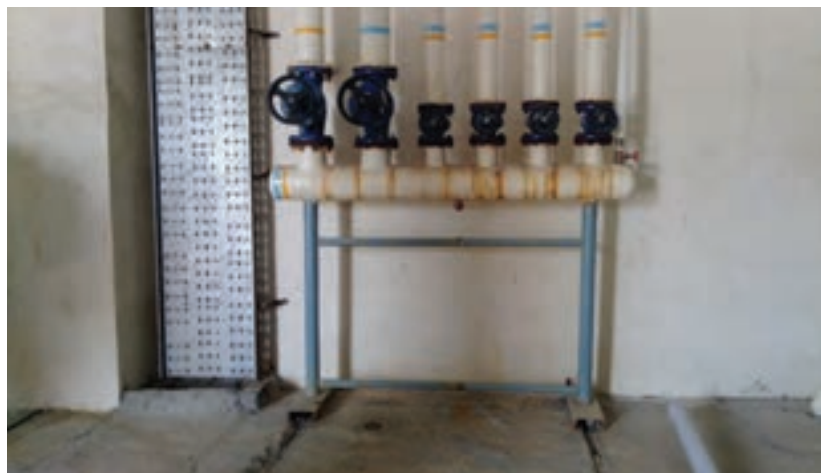
شکل ۲- نصب پایه کلکتور
