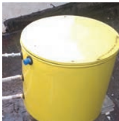
شکل ۳- مخزن انبساط باز با عایق
