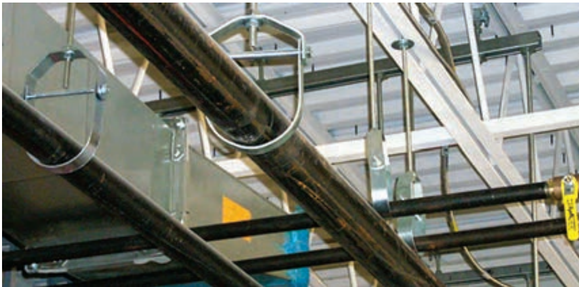
شکل ۱۲- نمونه‌ای از آویز سقفی
