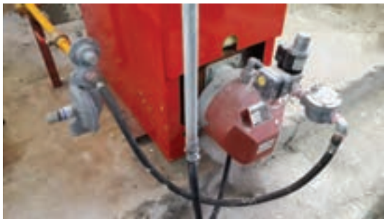
شکل ۲۹- اتصال مدار سوخت
