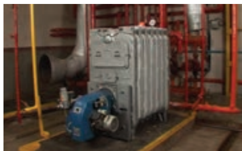
شکل ۱۷- دیگ فولادی ۴۰۰
