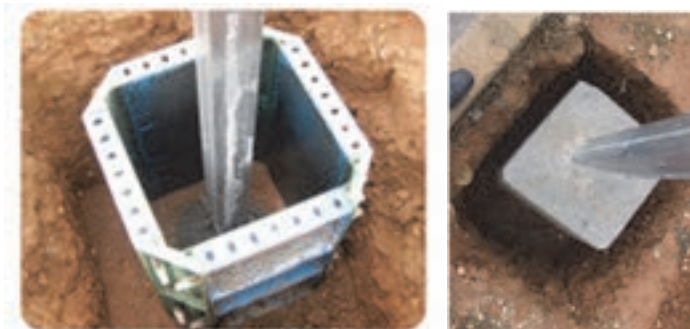
فونداسیون سازه گلخانه
