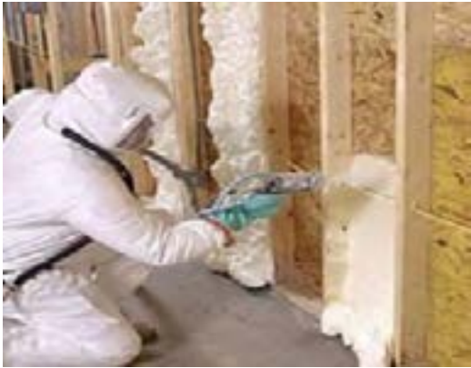
عایق‌بندی با نوعی فوم خمیری
