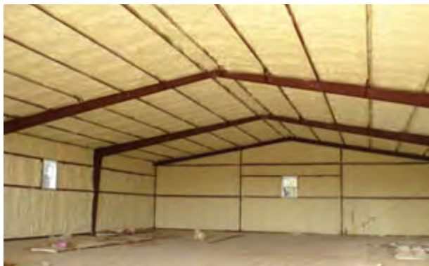
عایق‌بندی سقف و دیواره
