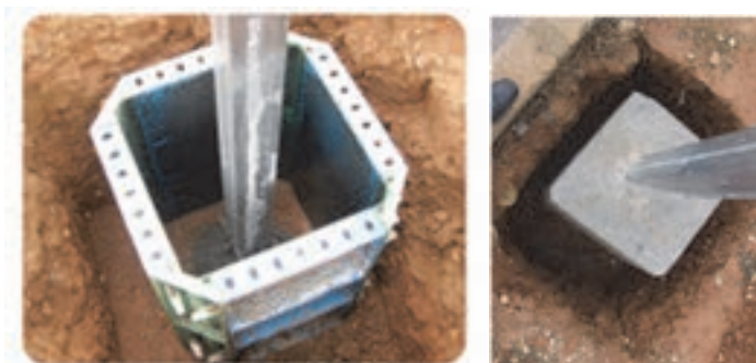
فونداسیون سازه گلخانه
