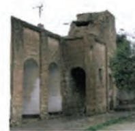
نمای بیرونی مسجد
