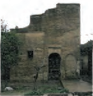
نمای بیرونی مسجد
