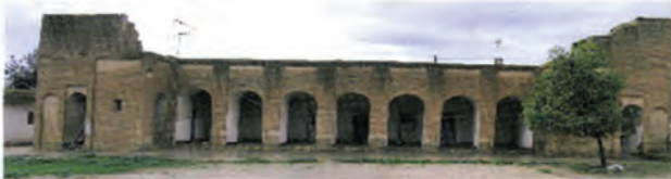
نمای بیرونی مسجد
