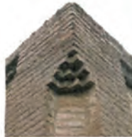
نمای بیرونی مسجد
