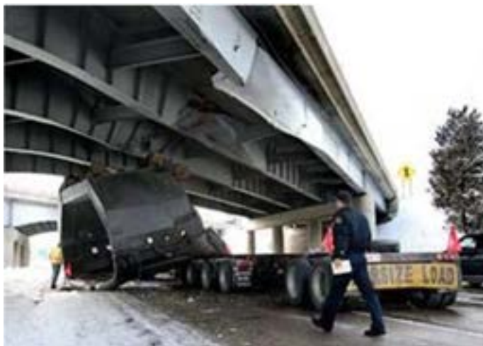
شکل ۲۶- عدم توجه به محدودیت ارتفاعی
