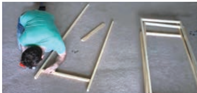
شکل ۱۹- ساخت قاب پارتیشن
