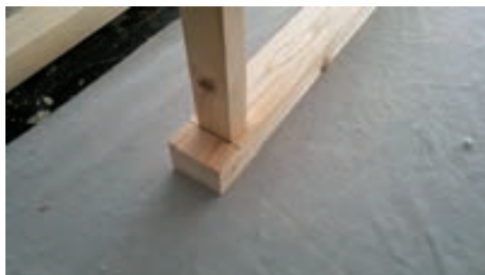
شکل ۴۷- استقرار قید افقی بر روی قید طولی
