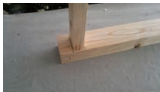
شکل ۴۹- زدن دو منگنه روی قید اول
