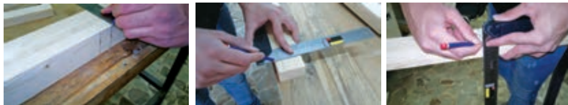
شکل ۴۴- خط‌کشی و انتقال اندازه‌ها به ضخامت چوب
