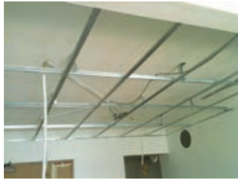
شکل ۱۶- بررسی تأسیسات و محل عبور سیم برق
