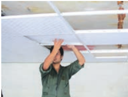
شکل ۱۷- نصب و تنظیم پنل در شبکه فلزی
