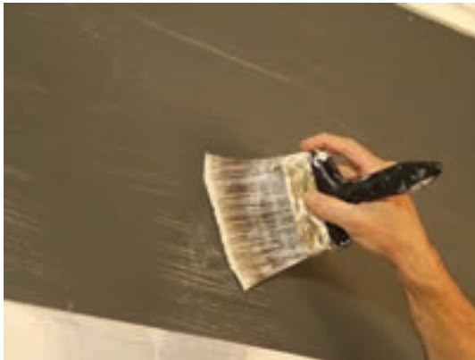
شکل ۸۴- چسب زدن دیوار
