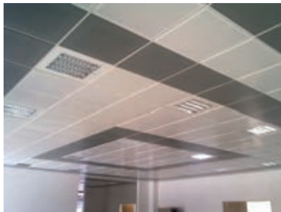
شکل ۱- اجرای سقف کاذب با مواد صداگیر
