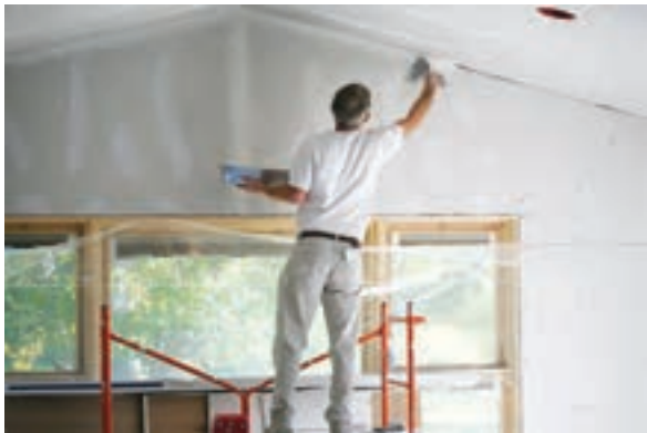
شکل ۱۸- پرداخت درز بین دیوار و سقف کاذب
