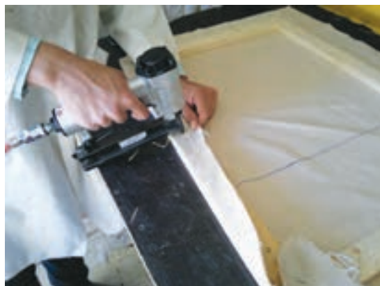
شکل ۳۳- منگنه زدن وسط قاب
