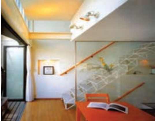
شکل ۲-۴۰- پله‌ای ساده با دستگردی بر روی دیوار مجاور آن
