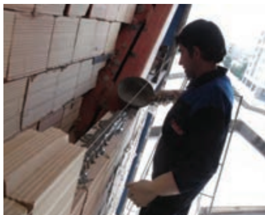
شکل ۴-۶- ملات ماسه سیمان جهت اتصال بلوک‌ها
