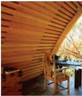
شکل ۲-۱۲- در سقف‌هایی که به زمین می‌رسند باید به سرگیر شدن قسمت‌های نزدیک زمین توجه داشت.
