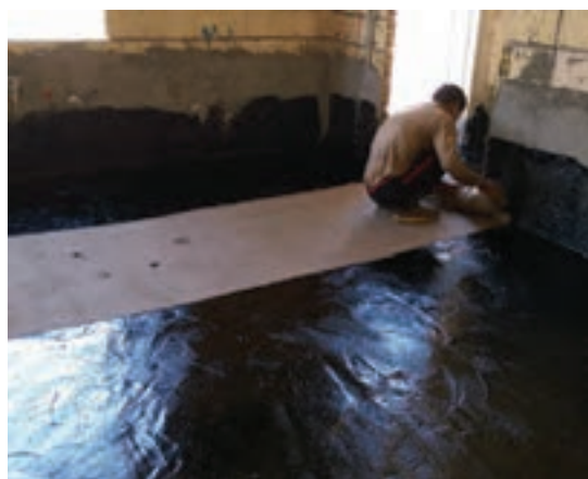
شکل ۴-۱۱- اجرای قیرگونی کف فضای داخلی
