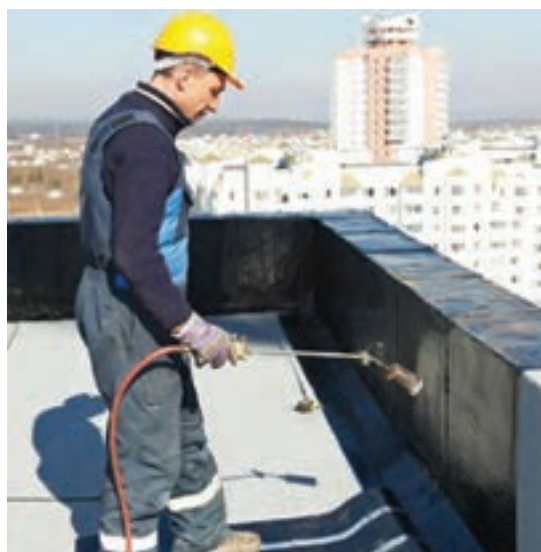
شکل ۴-۱۳- اجرای ایزولاسیون پیش ساخته بر روی دیوار جان پناه بام
