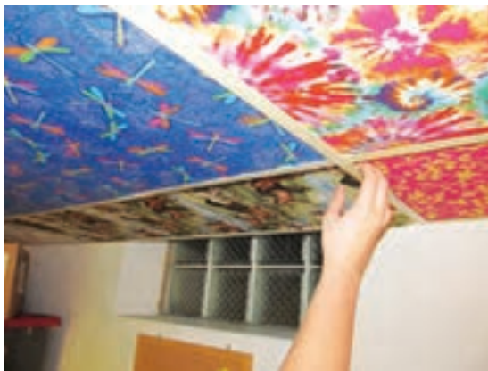
شکل ۲- سقف کاذب با پارچه نقاشی شده
