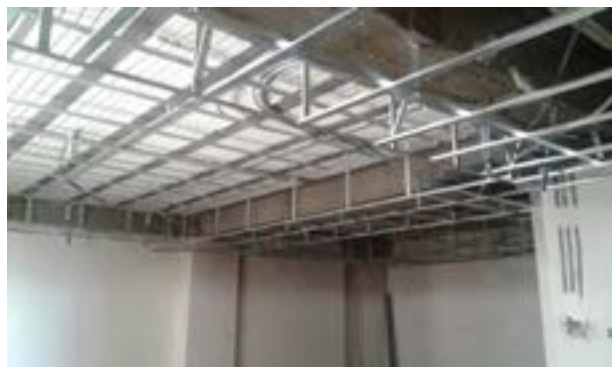
شکل ۱۶- بررسی تأسیسات و محل عبور سیم برق
