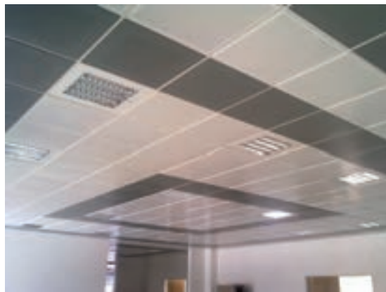
شکل ۱- اجرای سقف کاذب با مواد صداگیر
