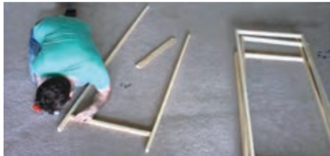
شکل ۱۹- ساخت قاب پارتیشن
