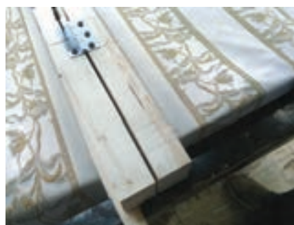
شکل ۷۴- بستن پیچ دوم برگه دوم لولا
