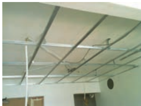
شکل ۱۶- بررسی تأسیسات و محل عبور سیم برق
