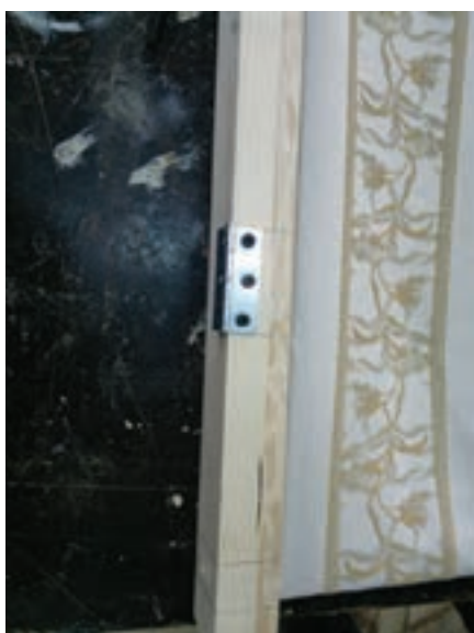
شکل ۷۲- محکم کردن برگه اول لولا با ۳ پیچ
