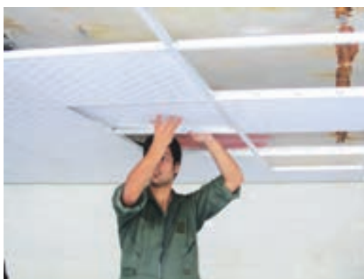
شکل ۱۷- نصب و تنظیم پنل در شبکه فلزی
