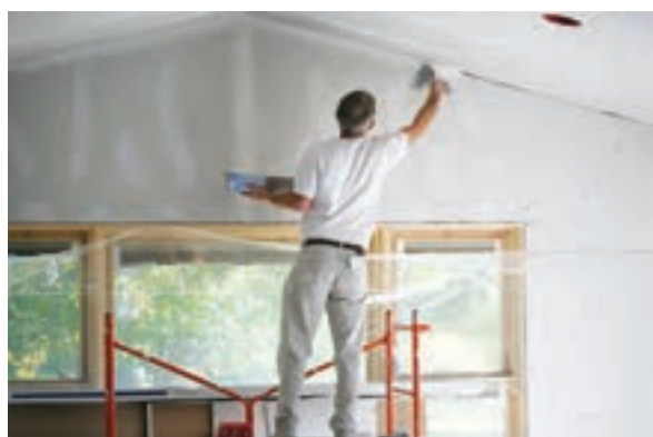
شکل ۱۸- پرداخت درز بین دیوار و سقف کاذب
