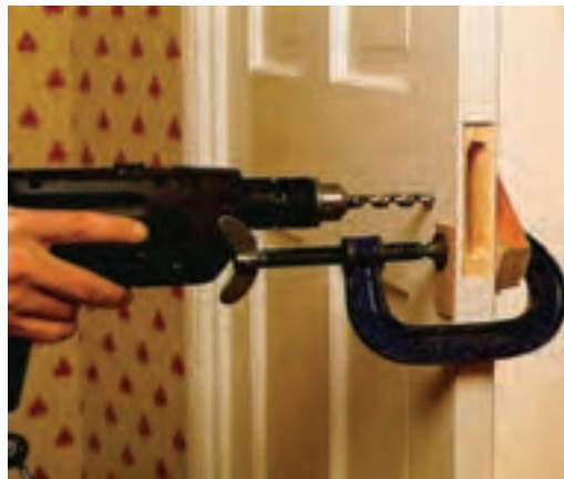
شکل ۱۰-۴۸- سوراخ‌کاری ممل پلاک و دستگیره‌ی قفل.
