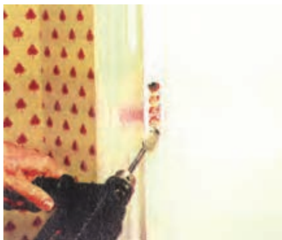
شکل ۱۰-۴۵-۱- تفلیهی ممل قفل با دریل.
