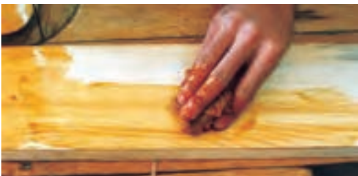
شکل ۲۸-۴- (رنگ‌های زیر کار) با کهنه دست زده می‌شود.
