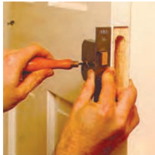
شکل ۱۰-۴۷- علامت‌گذاری پلاک و دستگیره‌ی قفل (روی در، با درفش).
