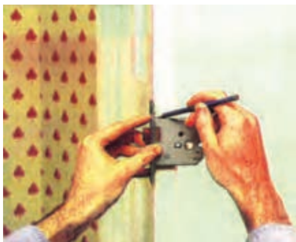
شکل ۱۰-۴۴-۱- فماتکشی ممل قفل (روی نرِ کار).
