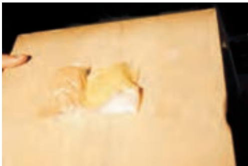
شکل ۹-۴- بتونه روی تخته بتونه تهیه و سافته می شود.
