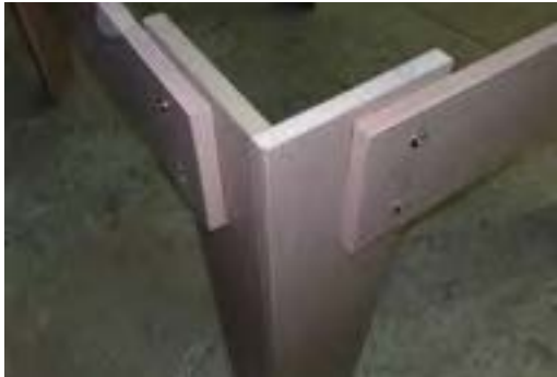
شکل ۱۲-۱۶- اتصال پایه به قید توسط پیچ فیکس.
