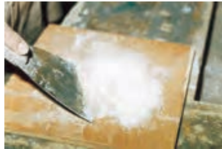
شکل ۱۲-۴. پودر مل و سریش را مخلوط کرده، در وسط تخته بتونه جمع کنید.
