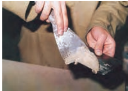
شکل ۸-۴- کاربرد لیسه و کاردک هنگام بتونه کاری.
