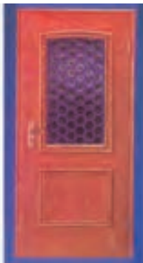
شکل ۱۱-۵- در شیشه‌خور با شیشه‌های مشجر رنگی.
