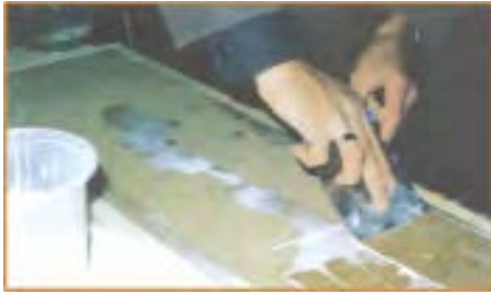
شکل ۵-۳۲- نمونه‌ی پخش کردن چسب به وسیله‌ی کاردک.
