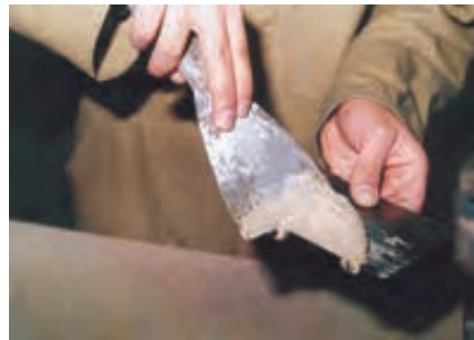
شکل ۸-۴- کاربرد لیسه و کاردک هنگام بتونه کاری.
