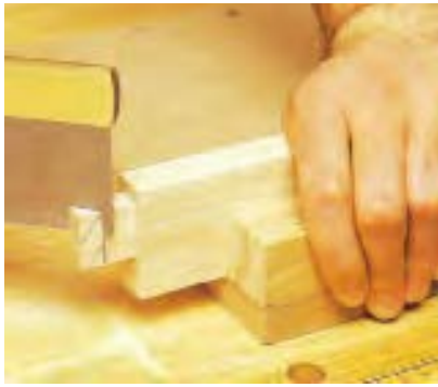
شکل ۹۹- به اندازه (ساختن زبانه با اره‌ی ظریف‌بُر (پشت‌دار)).
