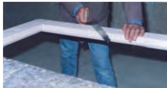
شکل ۱۱-۲۶- ایجاد شیار با اره‌ی دستی.
