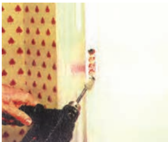
شکل ۱۰-۴۵-۱- تفلیهی ممل قفل با دریل.
