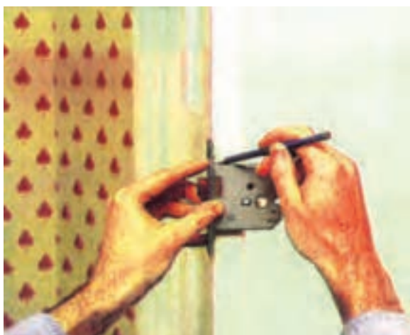
شکل ۱۰-۴۴-۱- فماتکشی ممل قفل (روی نرِ کار).
