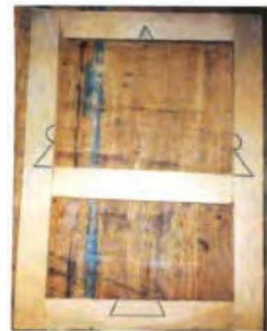
شکل ۱-۱۳- کاربرد علائم در هنگام مونتاژ. به علامت‌های قراردادی توجه کنید.
