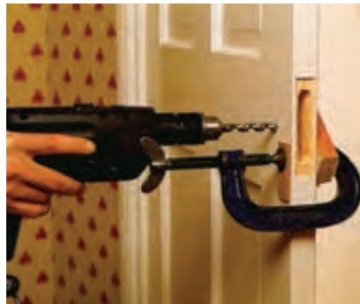
شکل ۱۰-۴۸- سوراخ‌کاری ممل پلاک و دستگیره‌ی قفل.
