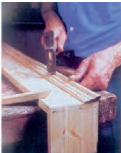
شکل ۱۳-۱۰- نصب زهوار با میخ.
