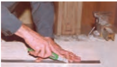
شکل ۵-۲۹- برش (روکش با کاتر)
