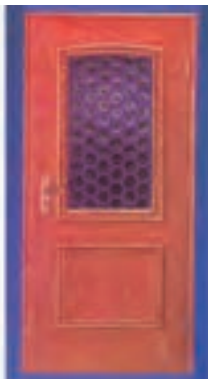
شکل ۱۱-۵- در شیشه‌خور با شیشه‌های مشجر رنگی.
