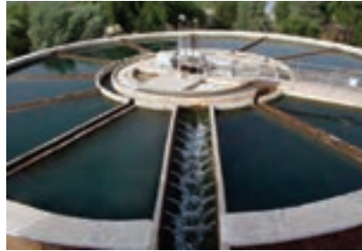
آب در تصفیه‌خانه
