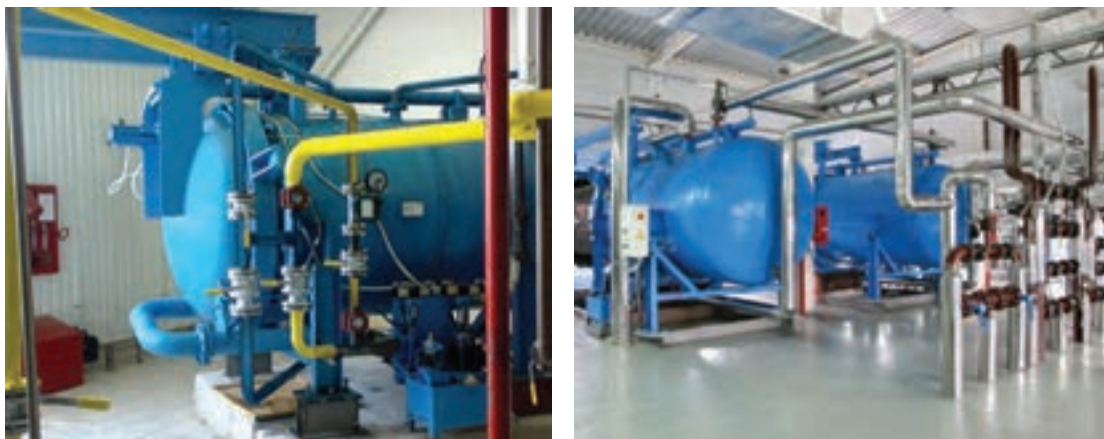
شکل ۱۲- سیستم زمستانه کردن روغن ها
