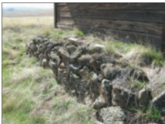
شکل ۳-۴۰ پی سنگی با سنگ لاشه
