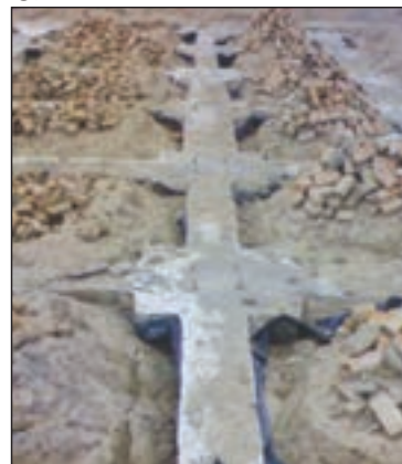
شکل ۳-۱۳۷ پی و شناژ بعد از بتن ریزی
