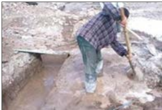
شکل ۳-۳۷ اجرای شفته آهک در فونداسیون
