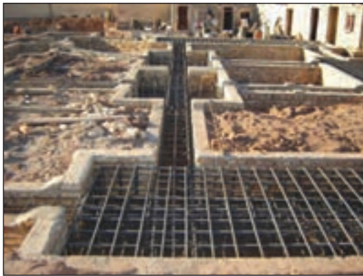
شکل ۳-۱۳۴ میلگردگذاری در پی کلاف بندی
