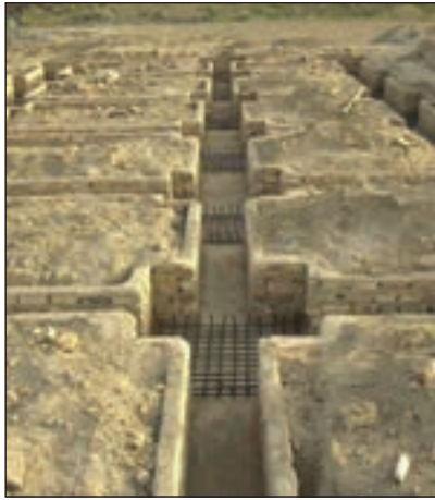
شکل ۳-۵۴ آرماتورگذاری پی تکی کلاف بندی شده
