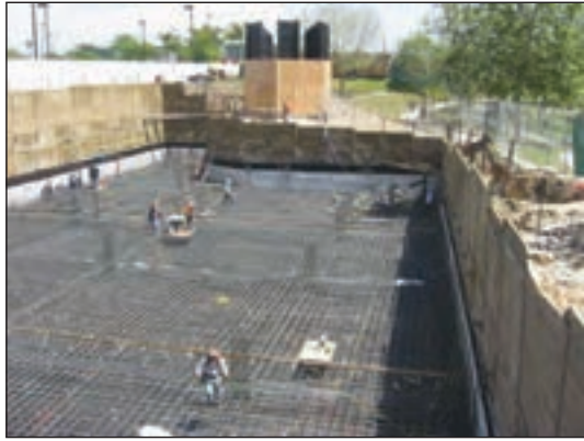
شکل ۳-۶۸ پی بتن مسلح یکپارچه (رادیه ژنرال)
