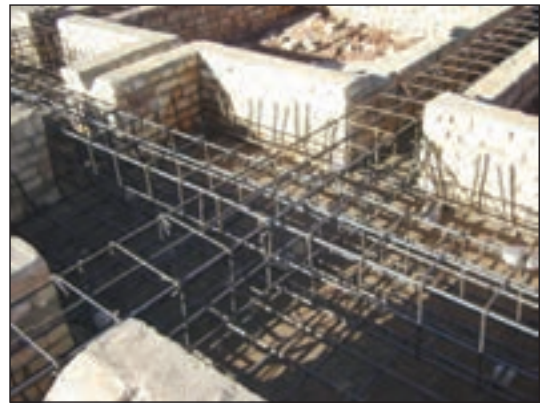
شکل ۳-۱۳۵ عبور میلگردهای شناژ در پی
