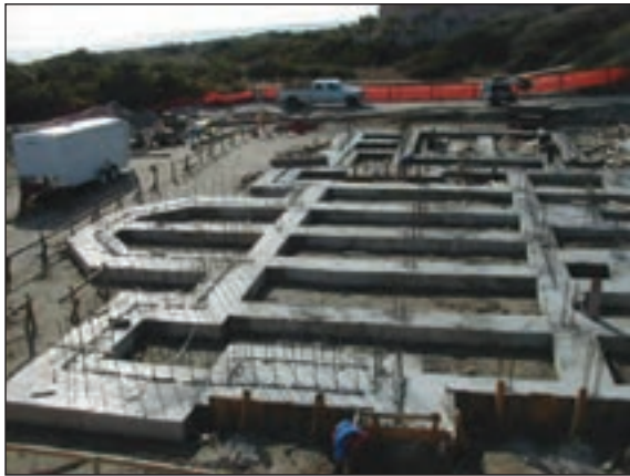
شکل ۳-۶۲ پی بتن مسلح نواری شبکه ای زیرستون
