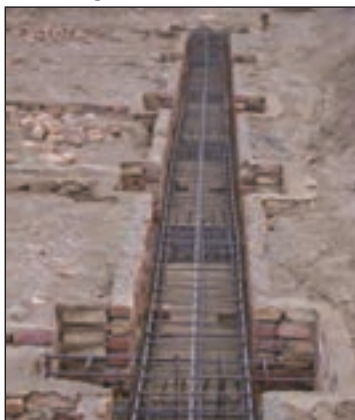
شکل ۳-۱۳۶ پی و شناژ قبل از بتن ریزی
