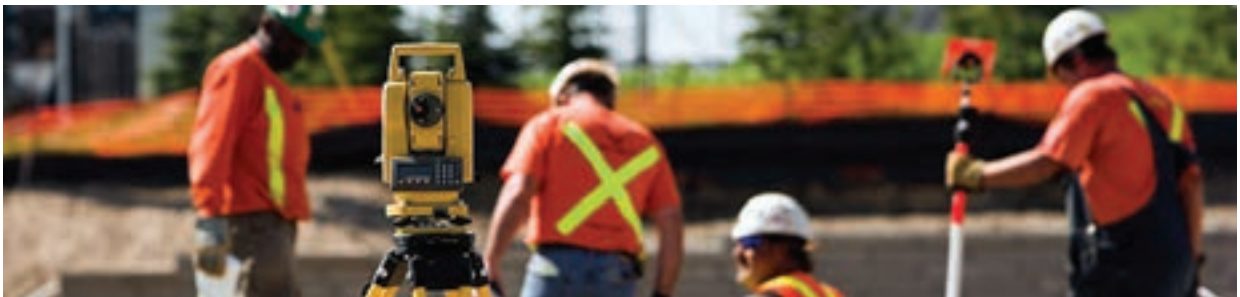
شکل ۴-۱. پیاده کردن با دوربین نقشه‌برداری
