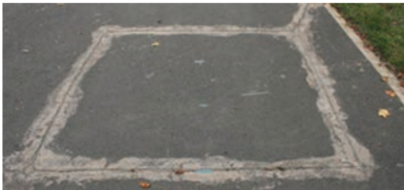
شکل ۲- نمونه نصب شده از حلقه‌های مغناطیسی
