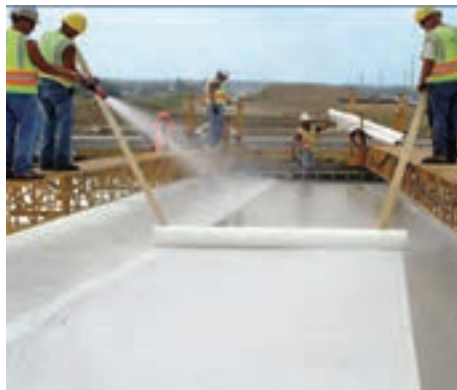
مرطوب کردن بتن و پوشش بانوار پلاستیکی
