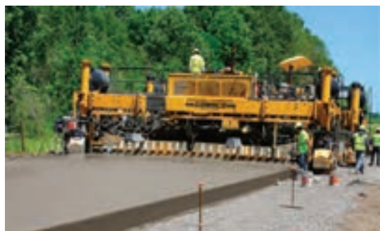
اجرای روسازی بتنی با استفاده از دستگاه
