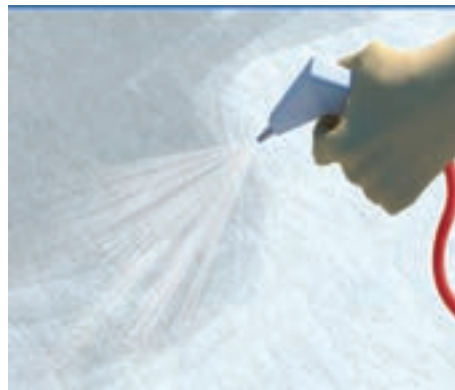
پاشیدن مواد نگهدارنده رطوبت بر سطح بتن
