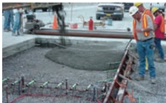
اجرای روسازی بتنی با استفاده از قالب‌بندی
