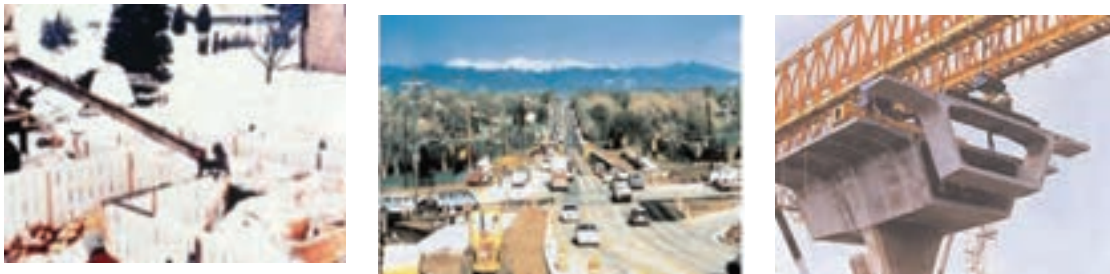
شکل (۳)- سیمان‌های زودگیر مواردی استفاده (چپ به راست): بتن‌ریزی در هوای سرد، بهره‌برداری سریع از روسازی راه جهت به حداقل رسیدن ترافیک و باز کردن سریع قالب‌ها
