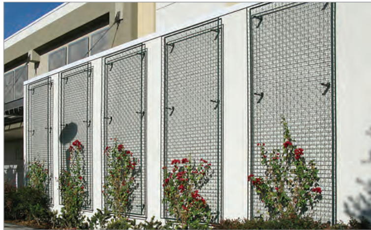
نصب پانل فلزی در سیستم شبکه‌ای داربستی روی دیوار و رشد گیاه روی آن
