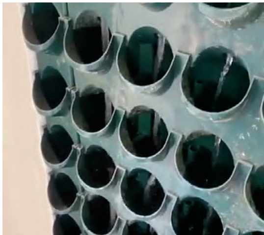
سیستم آبیاری در پانل‌های دیوار سبز
