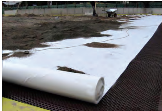
قرارگیری رول ژئوتکستایل در زیر بستر رشد
