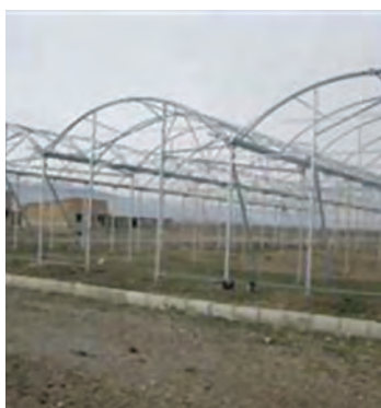
اسکلت گلخانه به سبک تونل - پیوسته
