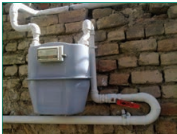
شکل ۸۱- ۴ یک کنتور ۱۰ متری نصب شده
