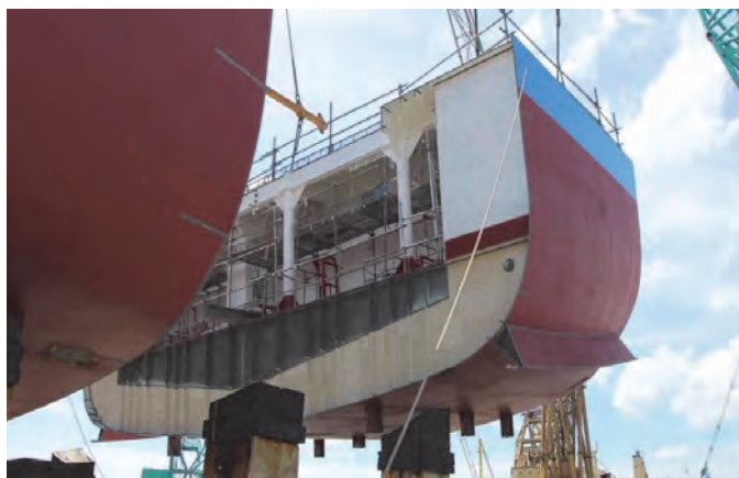
شکل ۸- اتصال بلوک‌های کشتی
