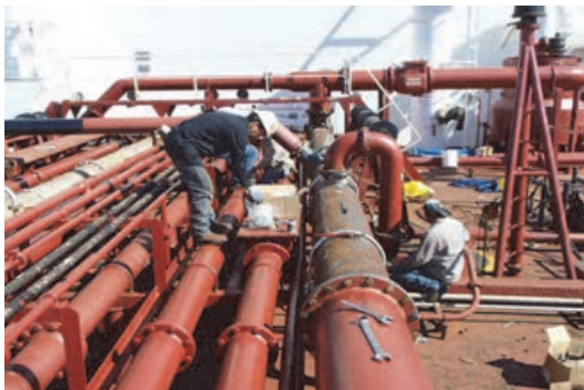
شکل ۷- در حال اجرای لوله‌کشی کشتی
