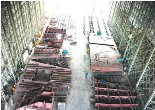
شکل ۵- جوش کاری بلوک کشتی
