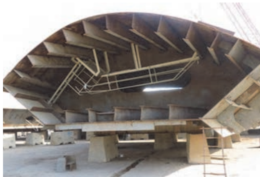
شکل ۶- اتمام جوش کاری بلوک کشتی
