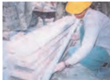
- مرحله اول: طریقه کنترل نما با شمشه (کنترل پیچیدگی نما)
