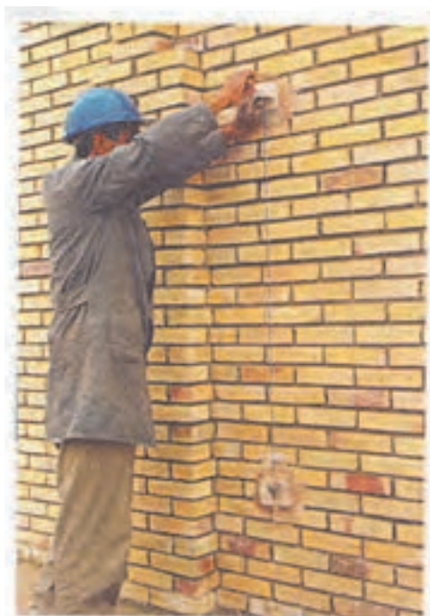
▲ شکل ۲۰ شاقولی کردن کرم‌ها
