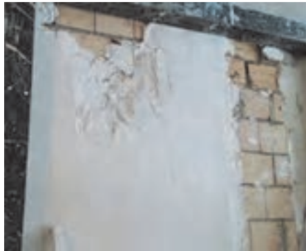
شکل ۲۵ ▲ پر کردن متن بین شمشه‌ها
