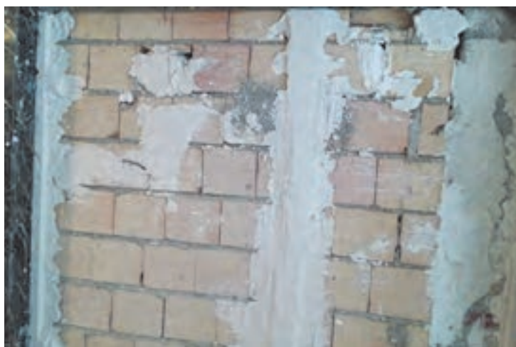
شکل ۲۴ ▲ شمشه‌گیری بین کرم‌ها
