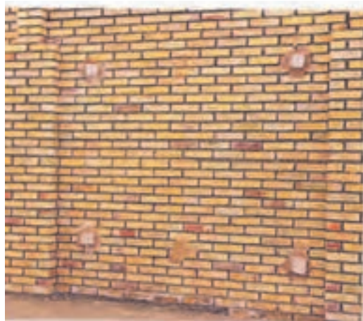
▲ شکل ۲۱ کرم‌بندی ابتدا و انتهای دیوار
