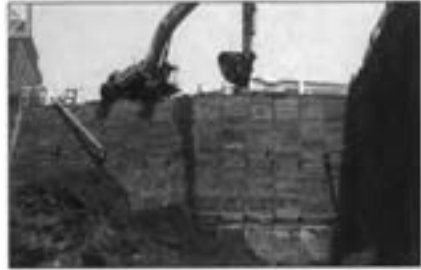
شکل ۱- ضرورت رعایت ایمنی در عملیات گودبرداری
