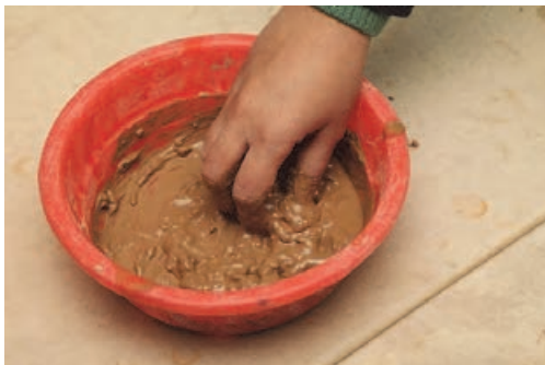
شکل ۱۱- تهیه گل یکنواخت با دوغاب
