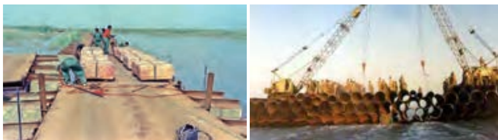
شکل ۶-۱- تصاویری از مراحل آمادگی، نصب و آماده‌سازی پل خیبر
