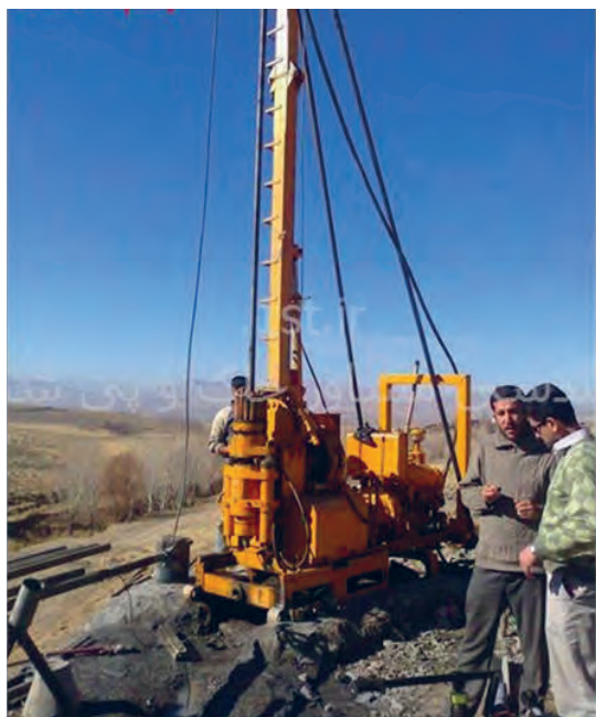
دستگاه حفاری مستقر شده بر روی فونداسیون
