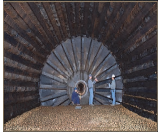
نمایی از داخل آسیای گلوله‌ای
