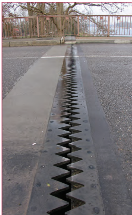
شکل ۲۳-۲ فاصله دندانهای شکل بین دو قسمت پل
