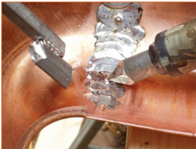
شکل ۲۲ - پرکردن درز اتصال به وسیله مذاب لحیم
