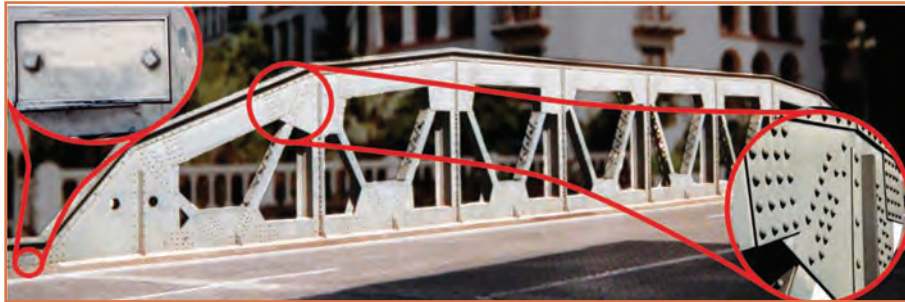
شکل ۳- اتصال دائم : پرچ
