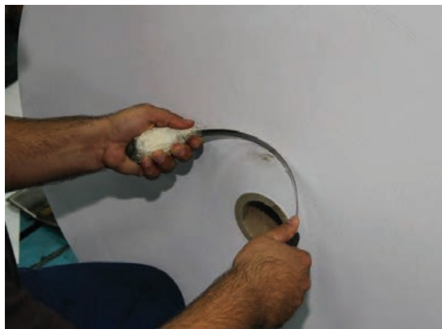
شکل ۵- برطرف کردن آسیب روی بدنه رول
