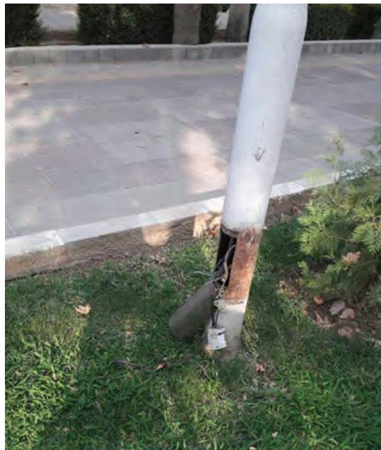
شکل ۲- وجود خرابی در سیستم برق‌کشی
