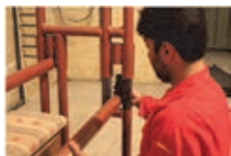
شکل ۱۷- نصب اجزاء دستگاه
