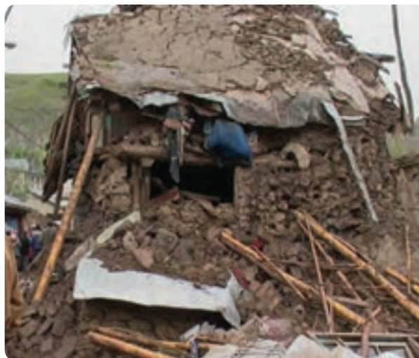
شکل ۲-۵- زلزله سال ۱۳۸۳- طالقان
