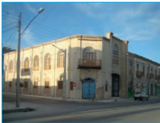
شکل ۷-۱۲- ساختمان دادگستری قدیم
