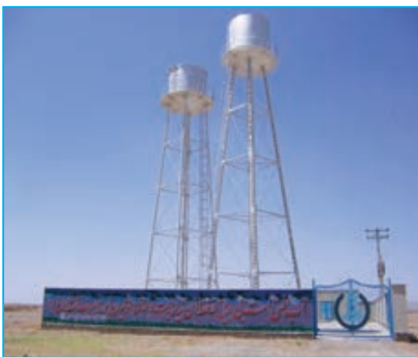
شکل ۱۰-۱۴- اجرای طرح آبرسانی بهداشتی روستایی
