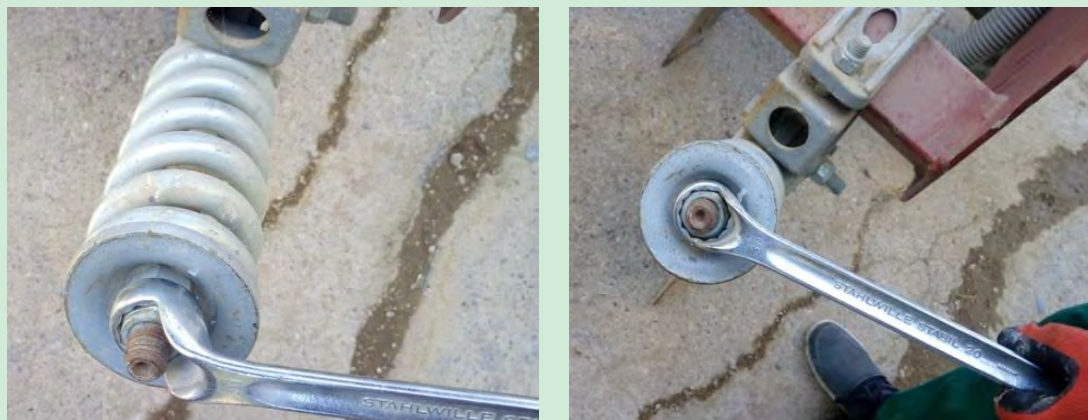
شکل ۴۵- آچارکشی نقاط اتصال اجزا و قطعات
