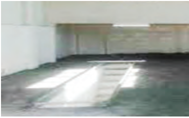
شکل ۱-۴- آستانه چاله سرویس
