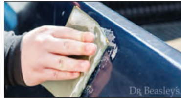
شکل ۱-۶۲- سنباده زدن ورق آهن
