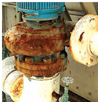
شکل ۵۰-۵- خوردگی الکتروشیمیایی قطعات فلزی
