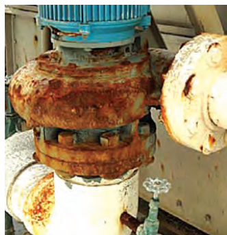
شکل ۵-۵۰- خوردگی الکتروشیمیایی قطعات فلزی
