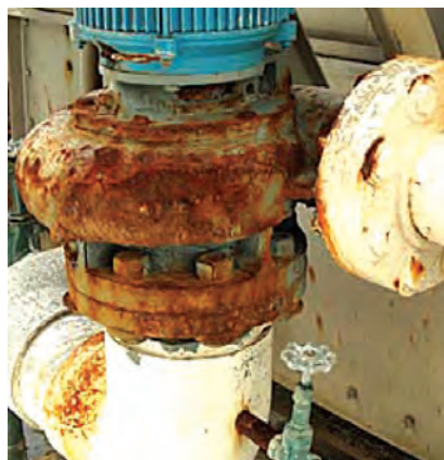
شکل ۵-۷- تأثیرات شیمیایی روی قطعات
