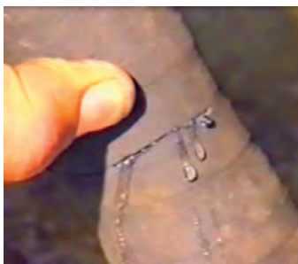
شکل ۶. نشتی از شیلنگ ها
