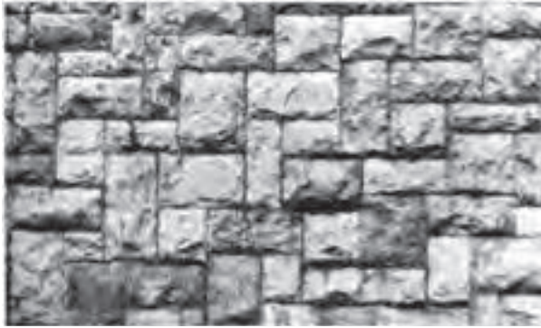
شکل ۹-۴- استفاده از سنگ بادبر در نما
