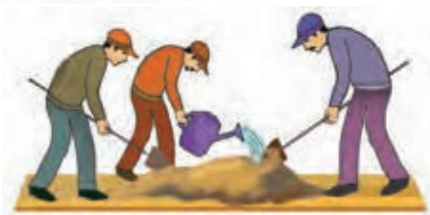
شکل ۳-۷- سرن‌کردن ماسه و مخلوط کردن ملات
