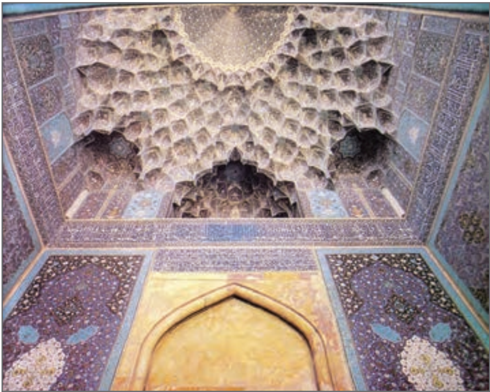
تصویر شماره ۲۱-۵- سردر ورودی مسجد امام با پوششی از یک شبکه پر حجم مقرنس‌کاری
