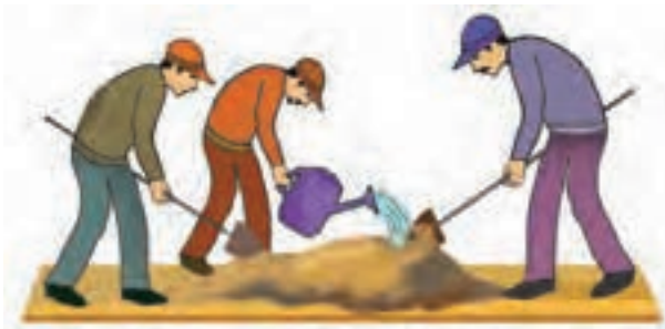
شکل ۳-۷- سرن‌کردن ماسه و مخلوط کردن ملات
