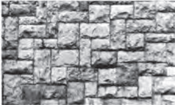
شکل ۹-۴- استفاده از سنگ بادبر در نما
