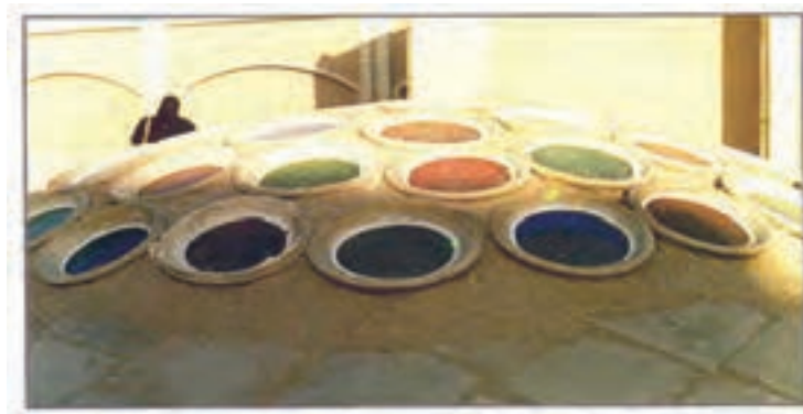
شکل ۲-۱۲- استفاده از گلجام در بازسازی سقف حمام
