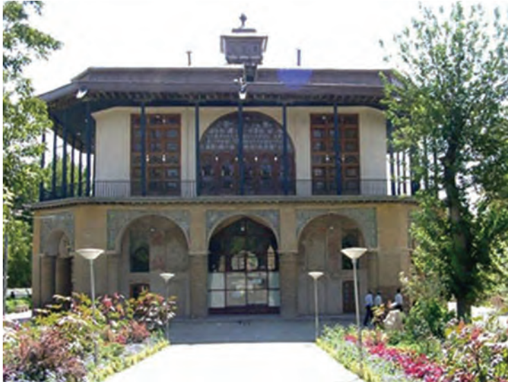
▲ شکل ۸-۱۲- عمارت چهلستون، قزوین
