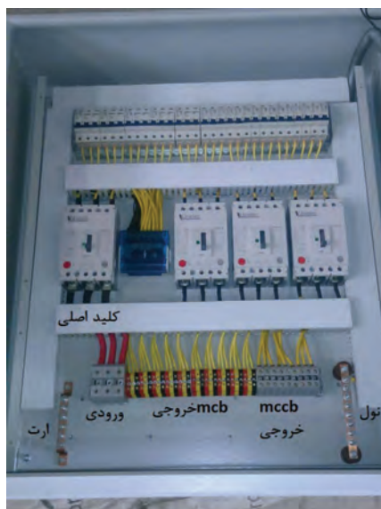
شکل ۳- ورودی از بالای تابلو
