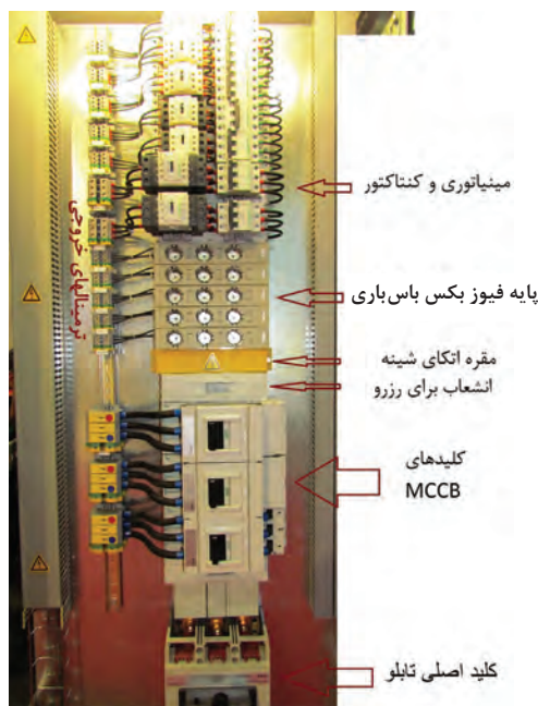
کلید قطعات روی پاس بار قرار گرفته شده اند
