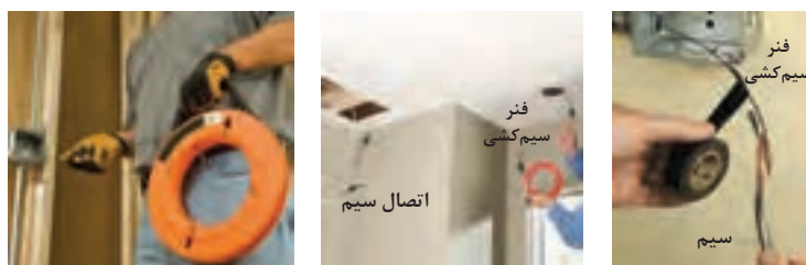
شکل ۳۷- چگونگی استفاده از فنر سیم‌کشی
