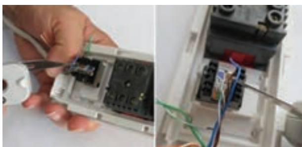
شکل ۶- خارج کردن سیم از ترمینال شبکه
