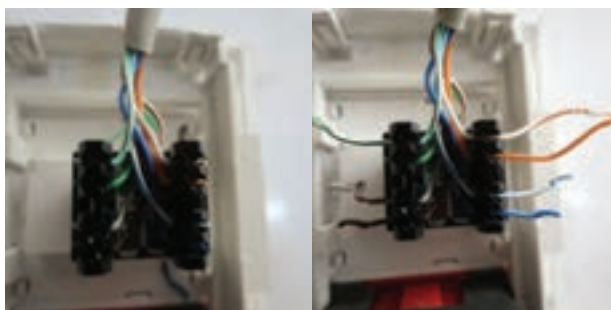
شکل ۵- اتصال کامل سیم در ترمینال
